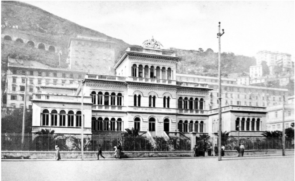
Fig. 4a. La scuola “Gerolamo Da Passano” (1899) in una foto del primo Novecento. All’eleganza dell’edificio si univano soluzioni logistiche originali come la cumulatività. La disposizione dei locali, pur mantenendo alle due sezioni (maschile e femminile) quella assoluta indipendenza fra di loro “che la morale consiglia e i regolamenti impongono”, permetteva di avere una sola portineria, una sola gabbia di scala, una sola cucina ed un’unica direzione.
